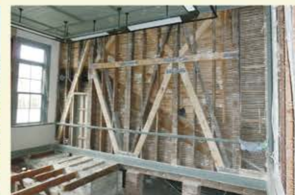
改修工事の様子
