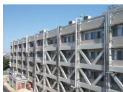
耐震補強されたD棟
